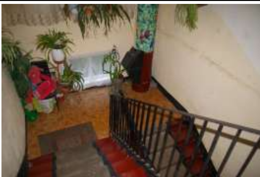
Būve ar kadastra apzīmējumu 1700 002 0093 011, koplietošanas telpa
